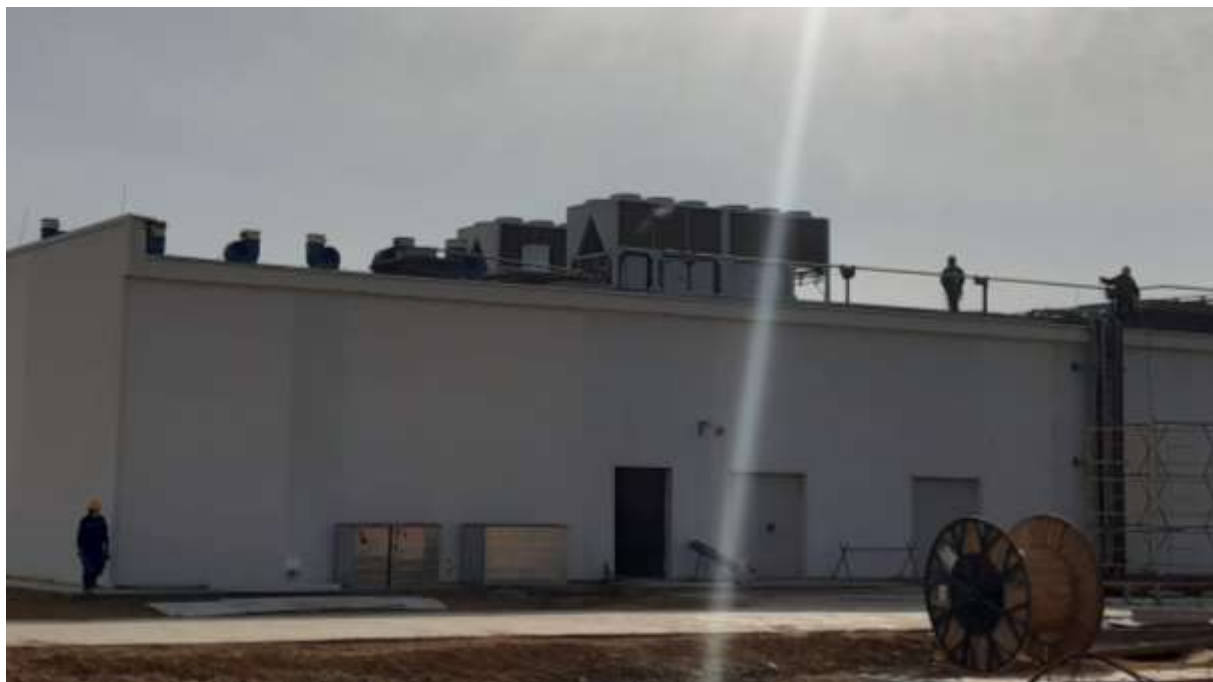
5-сурет-Моноблоқты чиллерді ғимараттың шатырына монтаждау процесі
