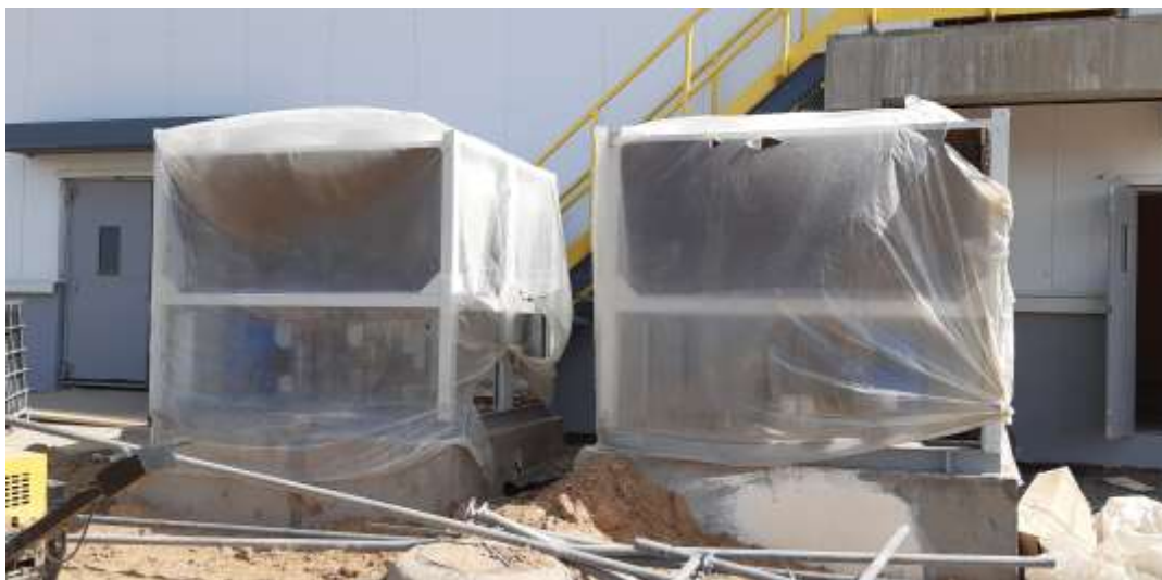
4-сурет-Моноблотты чиллерді ғимараттың сыртына монтаждау процесі
